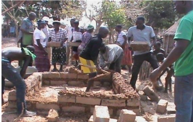
Construction de latrine
